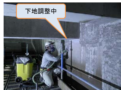
改造工事をする水槽内部では、防食塗装工事に着手しています。
