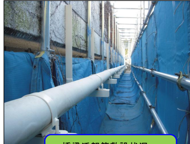
橋梁添架管敷設状況 (畑倉谷1号橋)
