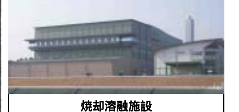
焼却溶融施設
