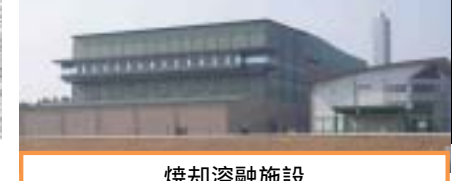
焼却溶融施設
